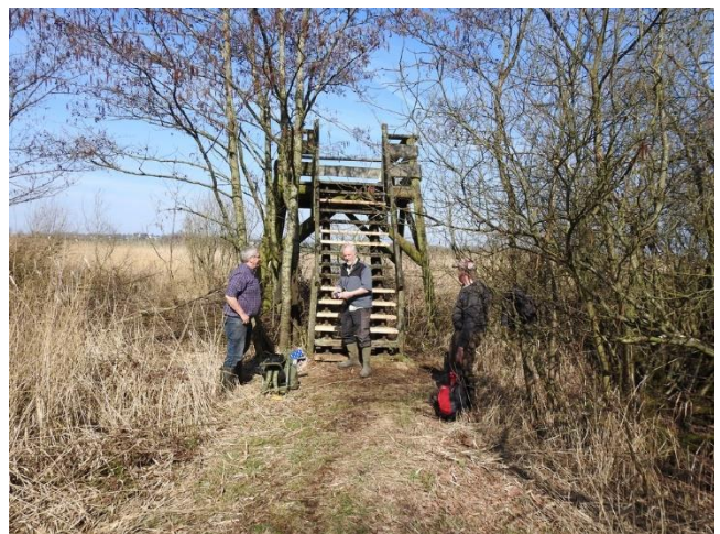
Færdigt arbejde. Tårnbestyrer Lars Peter (ved trappen) kan nu igen trygt invitere gæster på fuglekik ved Ketting Nor.
